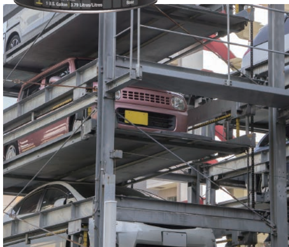
機械式駐車場
