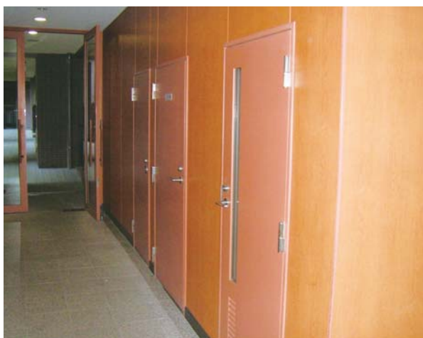
▶ マンション 鉄扉
