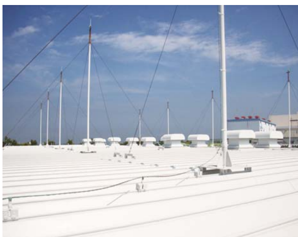
▶ 倉庫棟 折板屋根
