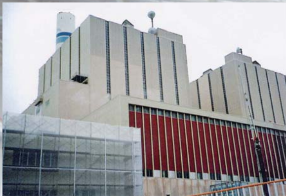
松島火力発電所
